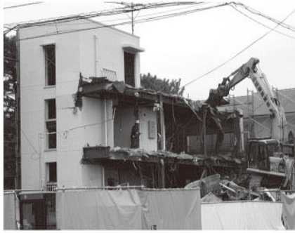
松島事務所解体工事
